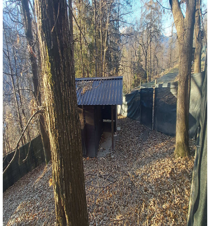
Rifacimento del tetto di stalletto destinato a custodia di ungulati con aggiunta dell'impianto elettrico
