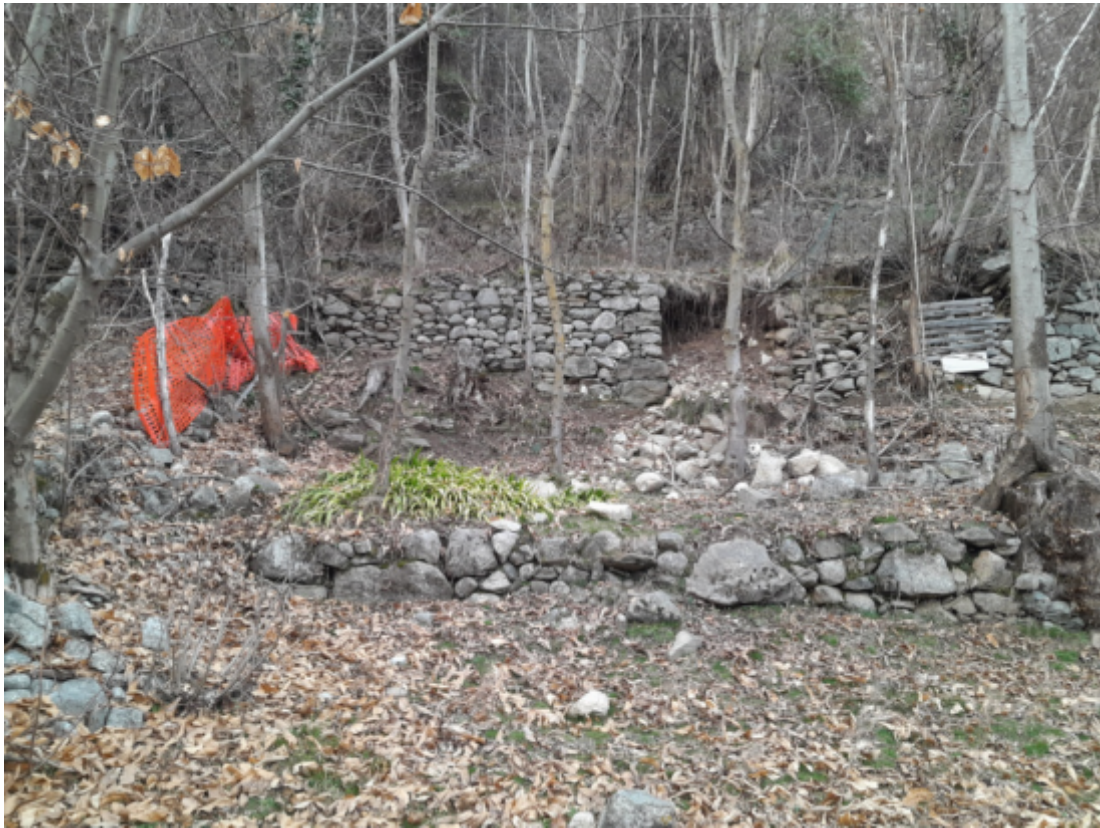
FOTO 7: Muro in pietra parzialmente crollato, da ripristinare
